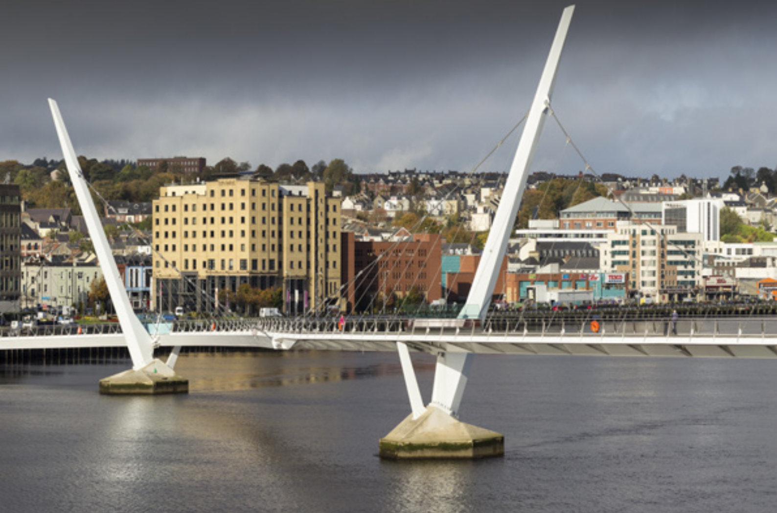
Peace Bridge de Derry
