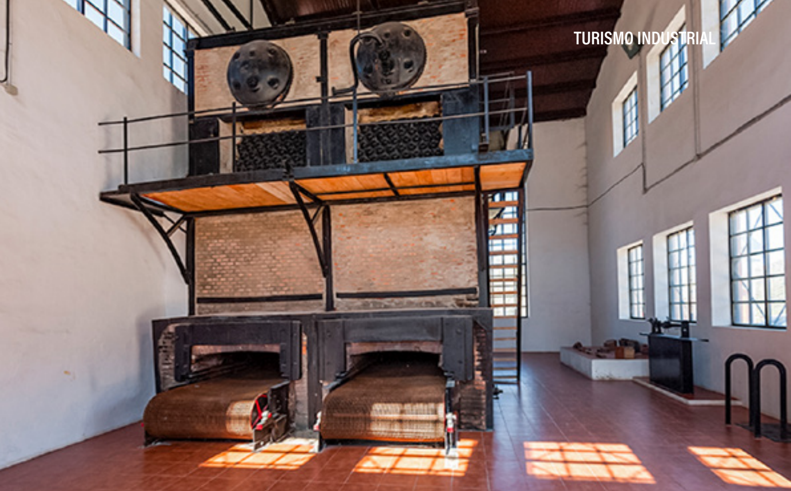
Edificio de los generadores, estos proporcionaban la energía en el interior de la mina
