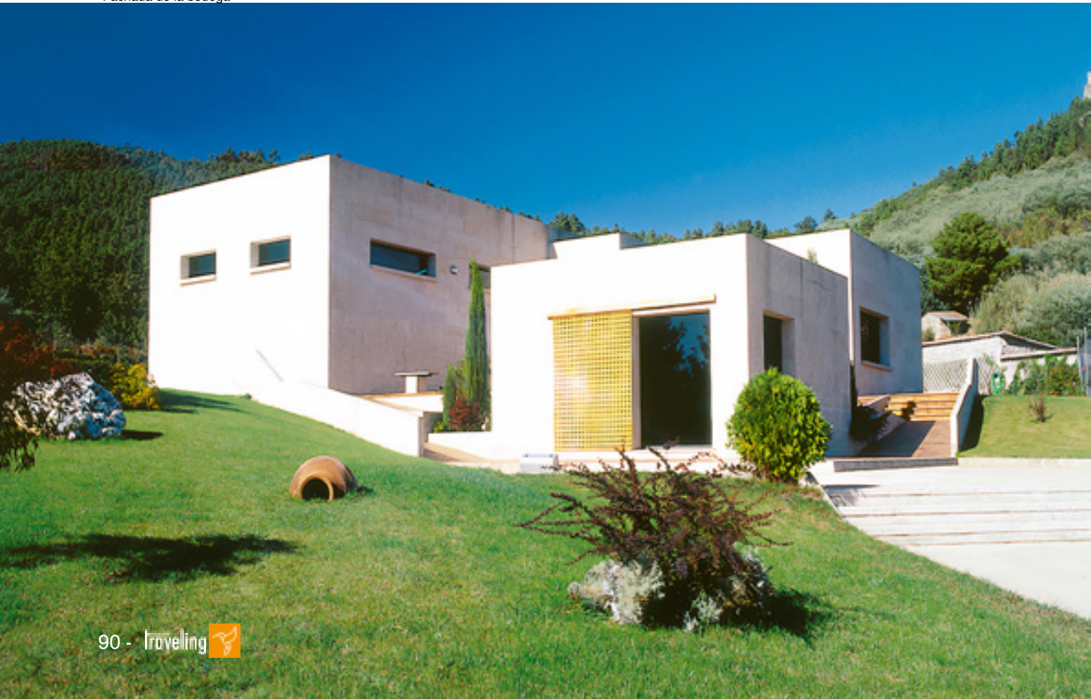
Fachada de la bodega
